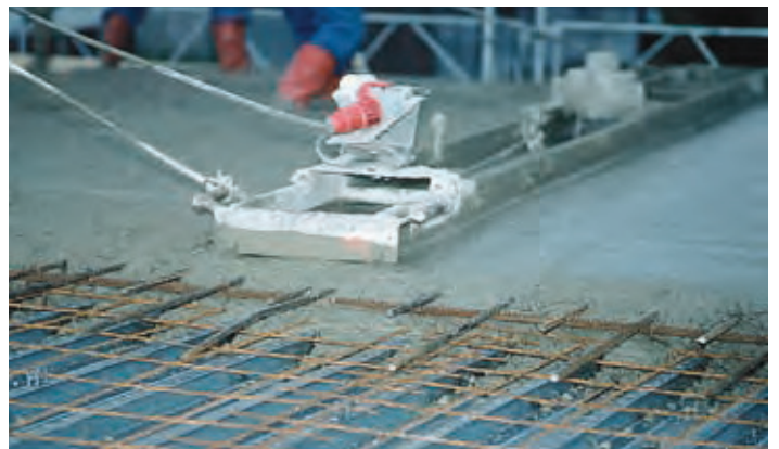
Betongpågjutning görs till färdig yta i ett moment.
