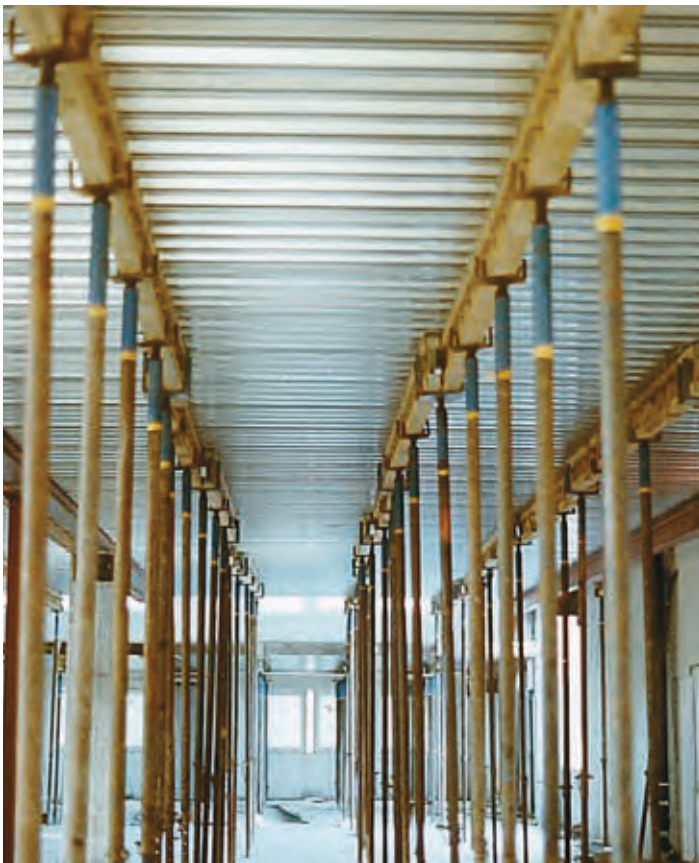
Ett glest lager bockryggar stöttar plåten under gjutfasen.
