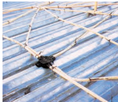
El- och vissa vvsinstallationer kan gjutas in på traditionellt vis. Infällt: Plåtändar tätas med profilskurva tätband, dessa medlev.
