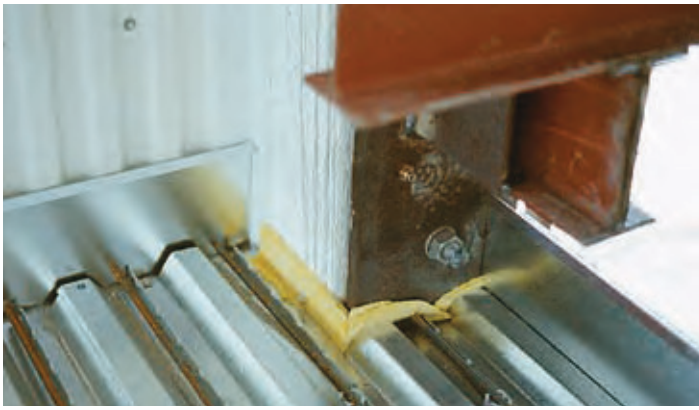
Det är enkelt att på plats utföra goda detaljanslutningar.
