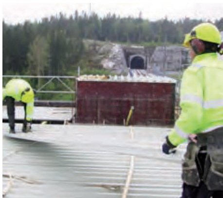
Peva 45 väger bara 7,5 kg/lm och kan oftast monteras utan lyfthjälpmiddel.
