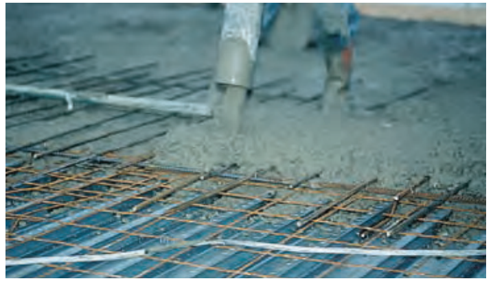
Betongen ska utbredas jämt så att plåten inte får lokala nedböjningar
