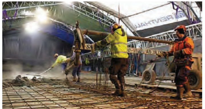
Vid pågjutning av större ytor planeras etappavstängning.
